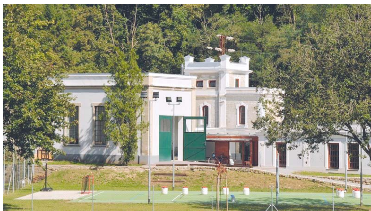
■ Stará vodárna U Obří hlavy v blízkosti řeky Dyje.
