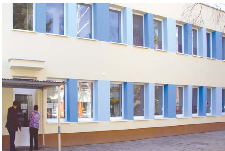
■ Školní budova na Dělnické se dočkala nejen nové fasády a zateplení, které šetří energie, ale i nových oken a dveří. Těšit se z pěkné budovy školy může denně 183 žáků. Pod MŠ Dělnickou spadá také MŠ Gránická, kterou navštěvuje 40 dětí. I tam se na vybavení podílí zřizovatel a ochotní rodiče.
