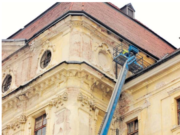
■ Koncem listopadu začaly práce na opravě fasády Louckého kláštera. Ve výškách se odbourávají nesourodé části omítky, které hrozily odpadnutím. Foto: xa
