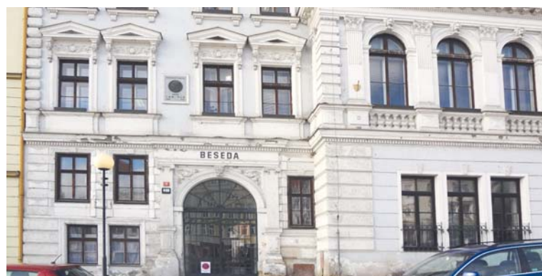
■ Správa nemovitostí města Znojma se také v letošním roce chystá na opravy vnějších fasád domů i fasád ve vnitřních traktech. Nového kabátu i rekonstrukce střechy se dočká také budova Znojenské Besedy na náměstí T. G. Masaryka. Foto: xa
