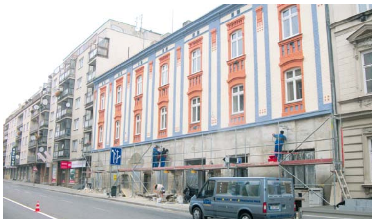
■ Působivě barevná část fasády je již hotova. Doplní ji moderní tmavé desky, kterými bude obloženo spodní patro budovy kina. Foto: Archiv ZL
