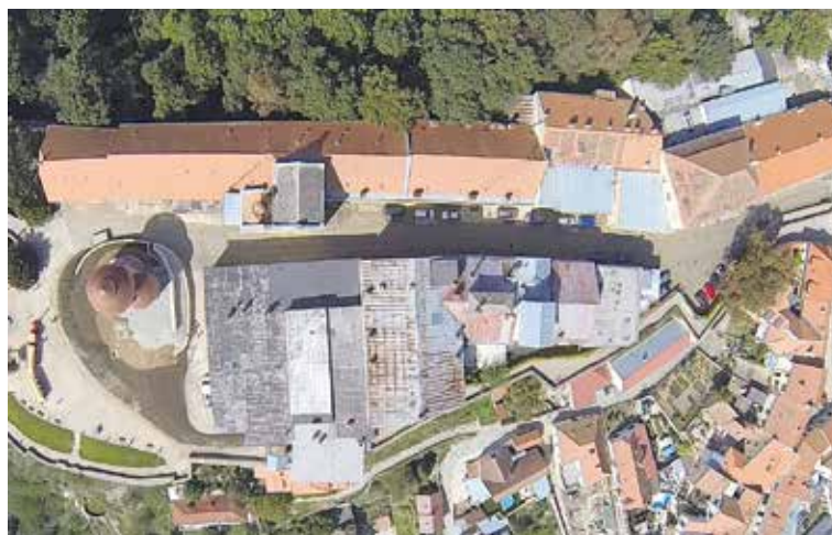
■ K již opravené budově pivovaru přibude i restaurace.
